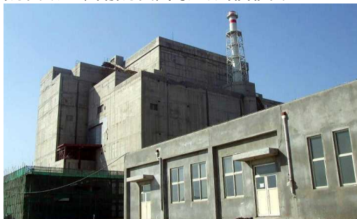
高速実験炉建物
