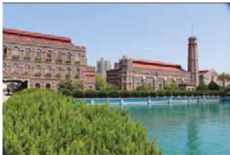
敷地内の貯水池と浄水場入口の建物
