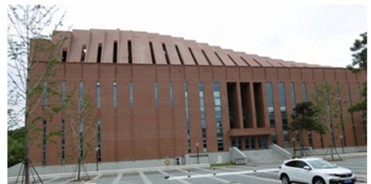
Photo.16 屋根が放物線状ドーム型校舎
