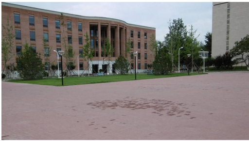
Photo.9 反対側が雁栖湖に面する校舎
